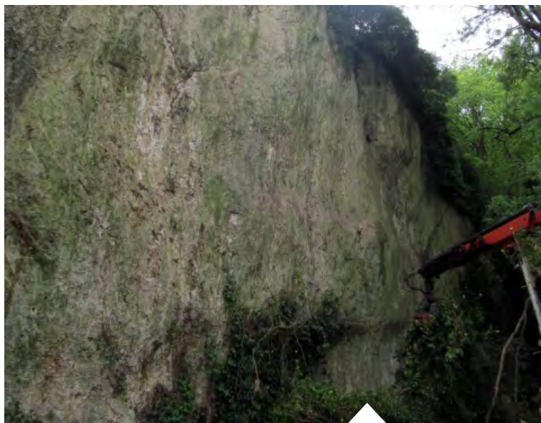
Travaux de sécurisation Falaise de la Salpêtrière - EPCC
