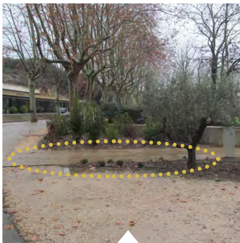
Installation de compteurs piétons/vélos intégrés au sol - EPCC
